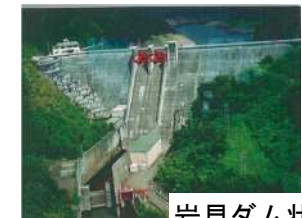
岩見ダム状況写真
