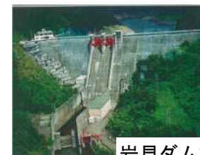
岩見ダム状況写真
