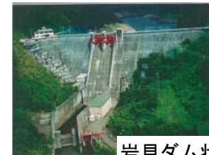
岩見ダム状況写真
