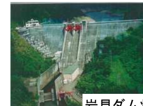
岩見ダム状況写真
