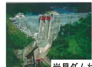
岩見ダム状況写真
