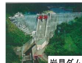
岩見ダム状況写真
