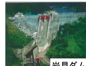
岩見ダム状況写真
