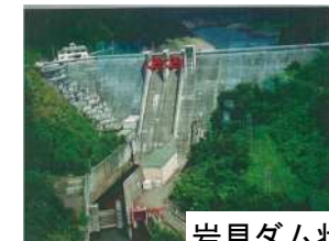
岩見ダム状況写真
