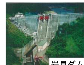
岩見ダム状況写真
