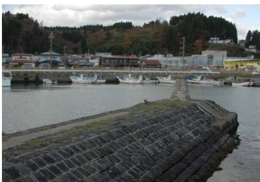
写真10 船川港 第二船入場防波堤
