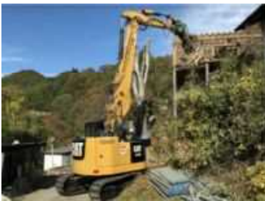
【解体用機械】 ブレーカ、鉄骨切断機、コンクリート圧砕機、解体用つかみ機 ※ベースマシンに解体用アタッチメントを装着させることで解体用機械として使用している等の事由により、複数の特定自主検査記録表等に同一のベースマシンが記載されている場合については、重複して加点評価の対象とすることはできません。
