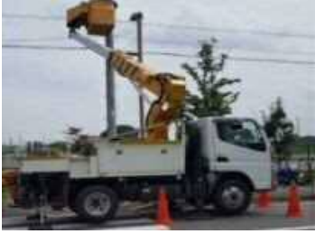
【高所作業車】 作業床の高さが2メートル以上のもの
