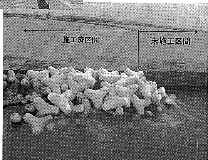
防波堤改良(消波ブロック)
