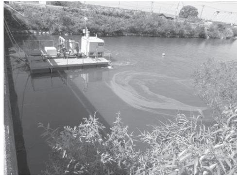
アオコ抑制装置による悪臭被害防止対策
