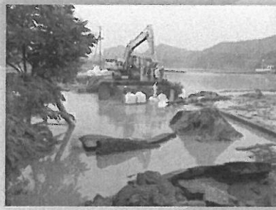
災害復旧作業
