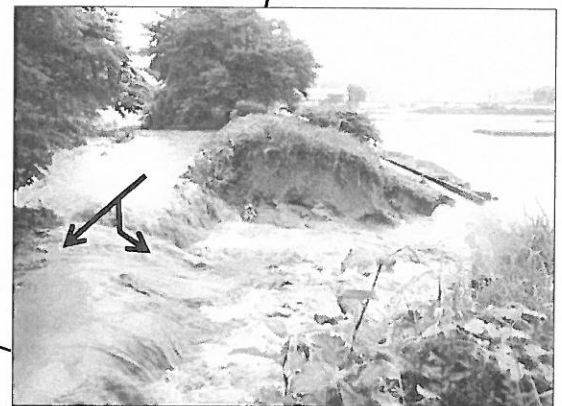
斉内川破堤状況(H27.7)
