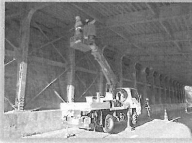
道路施設点検
