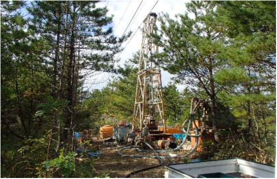
②槽設置、掘削開始
