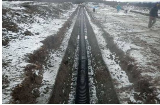
③浸透埋設管布設
