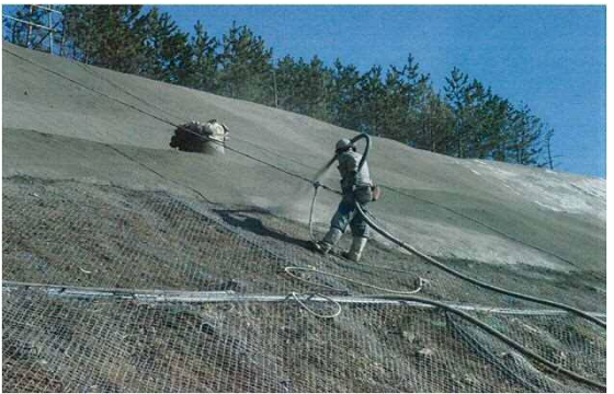
④モルタル吹付
