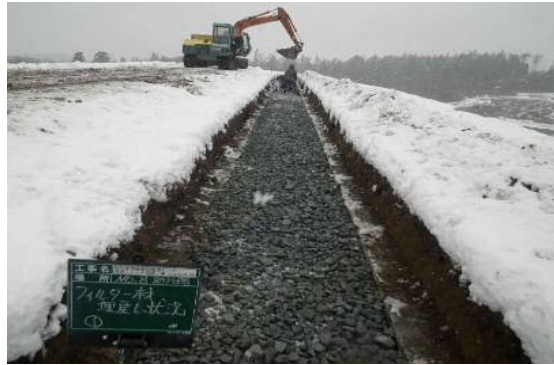
④フィルター材(碎石)投入
