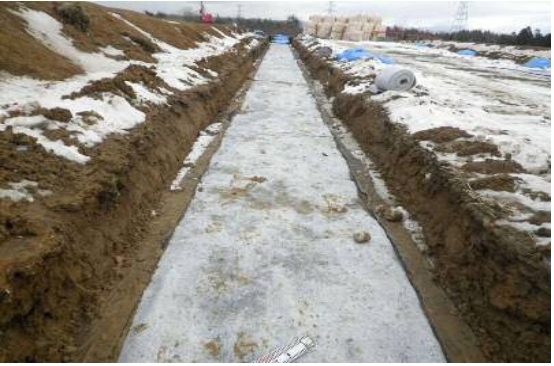
⑤雨水制御シート復旧
