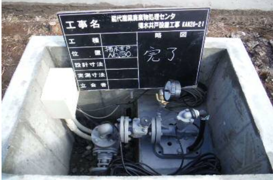
⑥井戸蓋等設置
