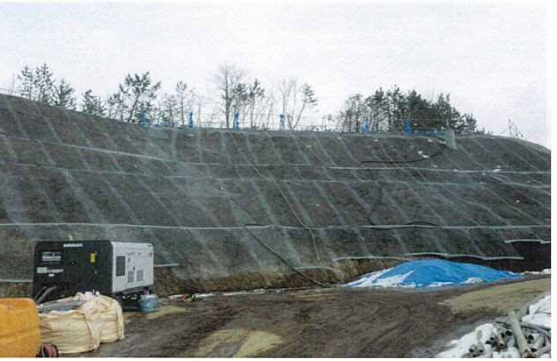
③ラス(金網)張り
