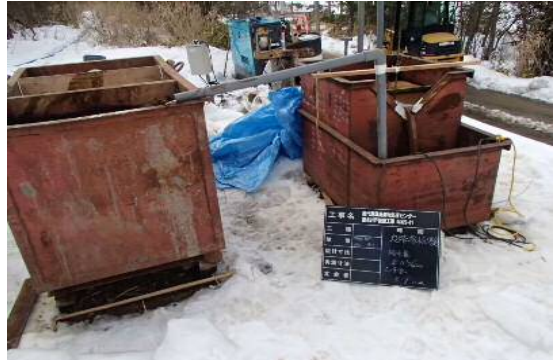
④揚水試験
