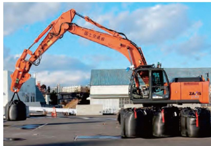
無人化施工による大型土のう設置事例
