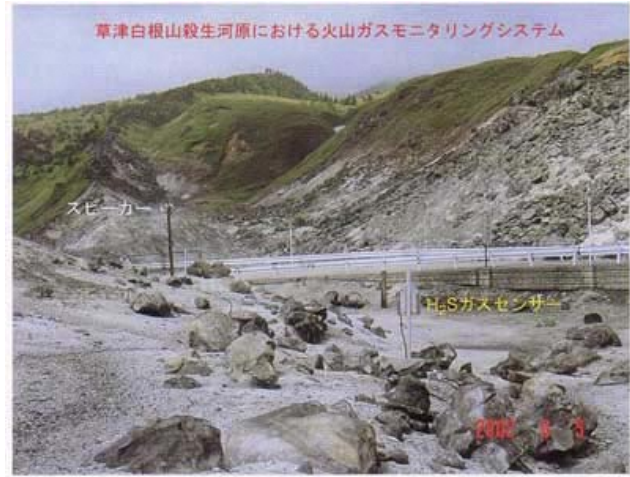
写真1 群馬県草津白根山に設置されている硫化水素ガス自動測定・警報装置 ガスセンサーは11箇所を設置されています。ガス濃度が基準値を超えるとスピーカーから放送されます。写真の殺生河原では、50 ppmと100 ppmの2段階で警報が出ます。
