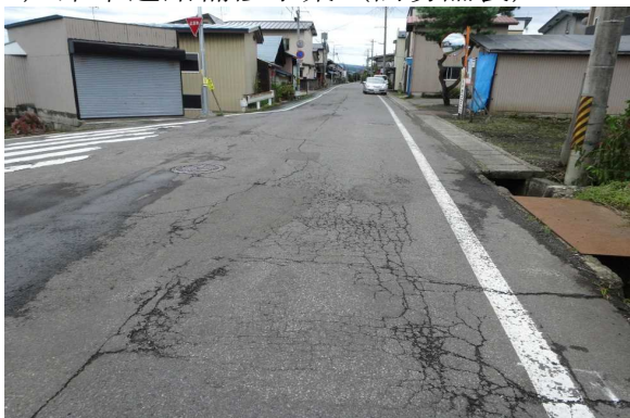
舗装補修 坊沢鷹巣線 坊沢(北秋田市)
