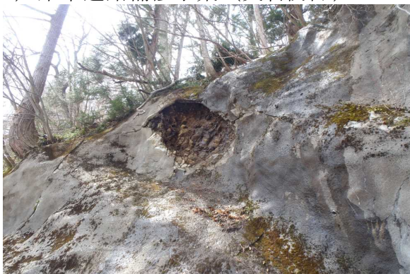
法面工 国道282号 坂梨峠(小坂町)
