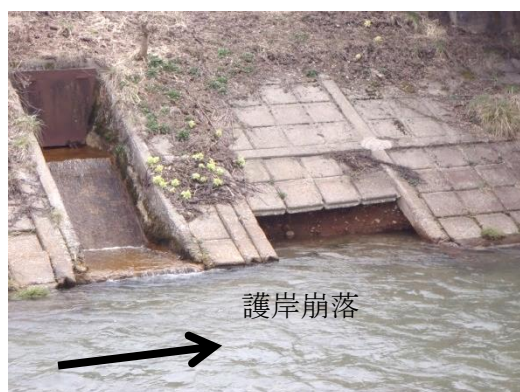
護岸工 間瀬川（鹿角市）
