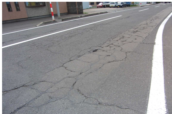
舗装補修 国道108号 薬師堂(由利本荘市)
