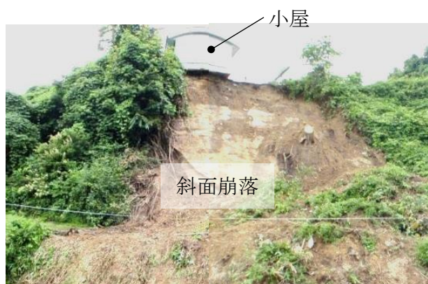
法面工 野田地区（大仙市）
