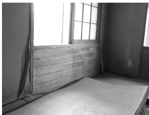
住戸内部（和室）の修繕
