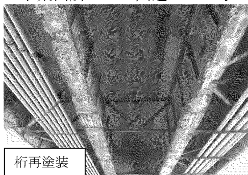
橋梁補修 国道107号 新二十六木橋 （由利本荘市）
