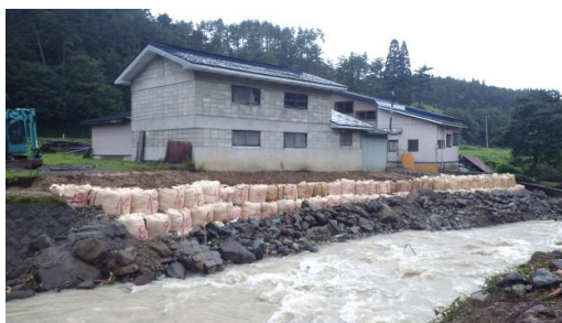
H26.8月豪雨 樫内川(鹿角市)の護岸決壊 → 応急対策(大型土のう等)
