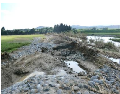
H25.8月豪雨 早口川(大館市)の破堤 → 応急対策(大型土のう等) → 原形復旧(護岸工)
