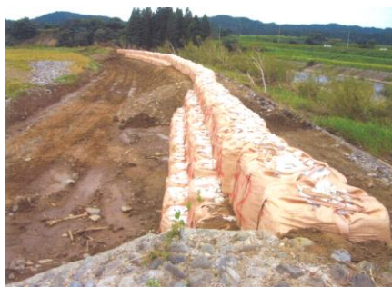
H25.8月豪雨 早口川(大館市)の破堤 → 応急対策(大型土のう等) → 原形復旧(護岸工)
