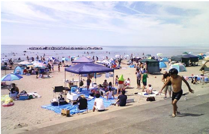
《離岸堤で守られた砂浜》 （西目海岸 由利本荘市）
