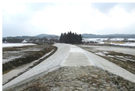
H25.8月豪雨 早口川(大館市)の破堤 → 応急対策(大型土のう等) → 原形復旧(護岸工)
