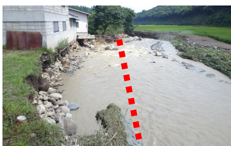
H26.8月豪雨 樫内川(鹿角市)の護岸決壊 → 応急対策(大型土のう等)
