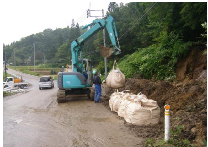
応急処理工 県単道路維持修繕事業((主)横手東成瀬線)
