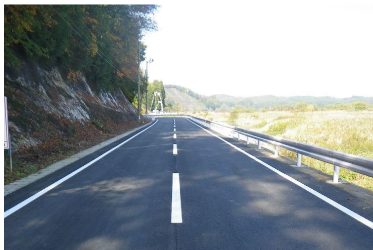
大仙市道 南外1号線 (平成27年3月20日完成)
