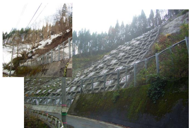
法面保護工 地方道路交付金事業((一)杉沢上小阿仁線)
