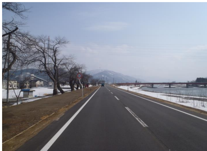
湯沢市道 中川原堤防線 (平成27年1月15日完成)
