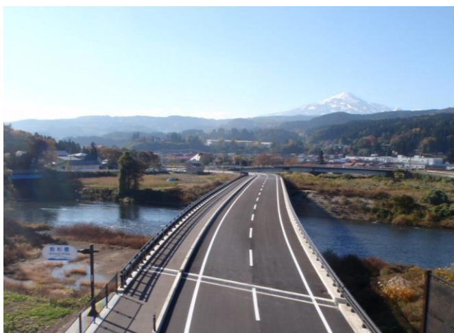
国道108号 由利本荘市矢島町城内～川辺 前杉バイパス (平成26年11月 1日供用)
