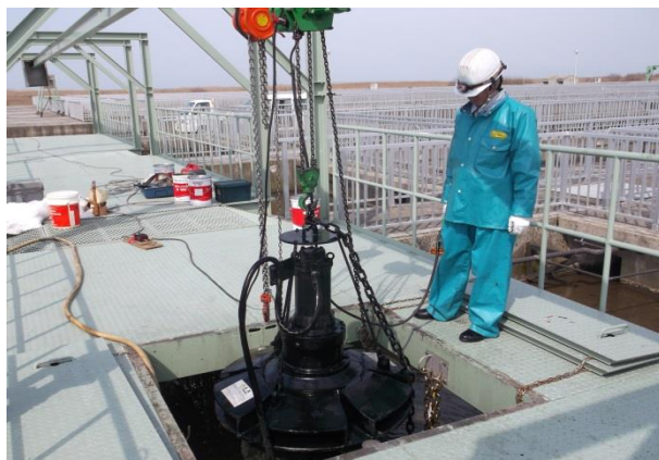
処理施設の点検
