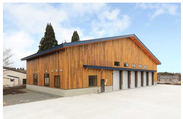
林業研究研修センター 機械実習棟
