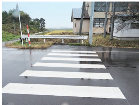
横断歩道の設置
