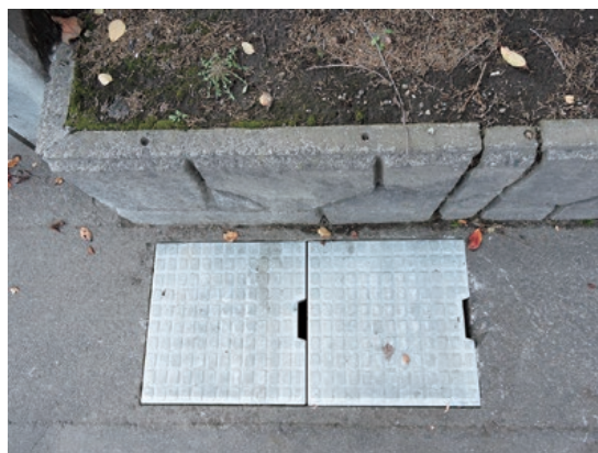
側溝蓋の補修
