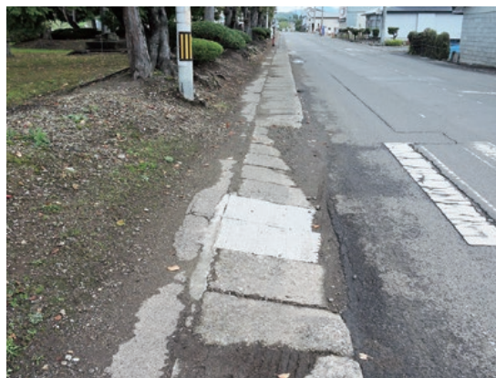
側溝蓋の補修
