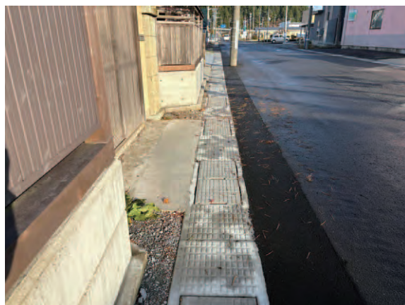
側溝蓋の設置
