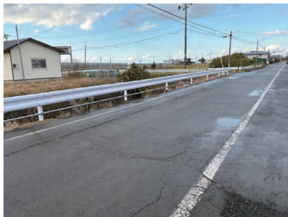
ガードレールの新規設置 路側帯の舗装
