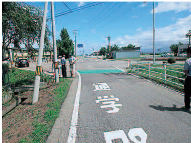
◇大雄小（横断歩道がない危険な通学路）
