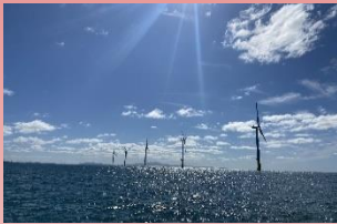
能代洋上風力(能代市)
