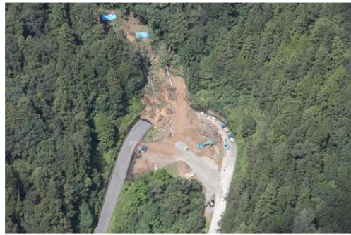
国道105号 土砂崩落（仙北市西木町上桧木内）
