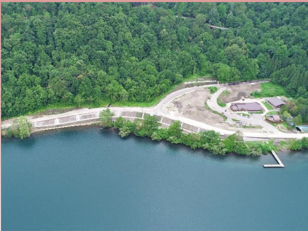
【鹿角地域】 国道103号 和井内工区
