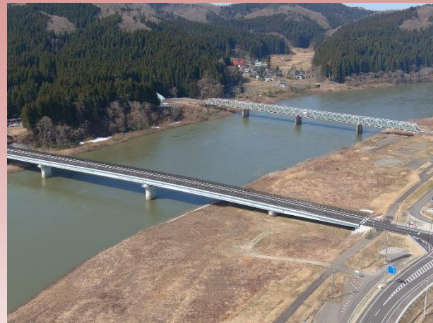
【秋田地域】 県道9号 秋田雄和本荘線 相川工区水沢橋
