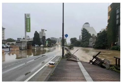
秋田岩見船岡線 歩道崩落（秋田市中通）
