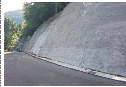
法面吹付工 河辺阿仁線(秋田市財の神)
