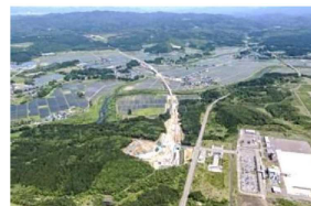
整備が進む日本海沿岸東北自動車道(大館能代空港付近)
