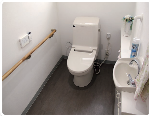
車いす使用者が利用できるトイレ
