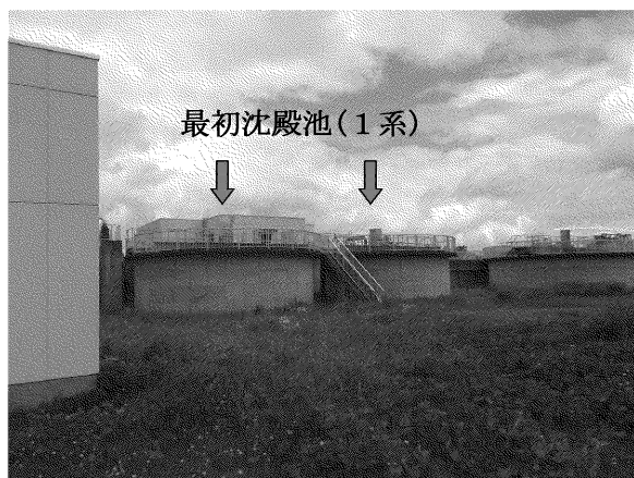
○処理場 [最初沈殿池耐震化]
