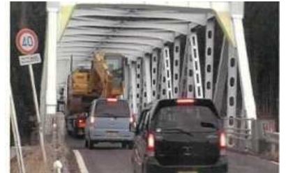
旧道の水沢橋の状況
