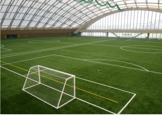
スカイドーム人工芝改修
