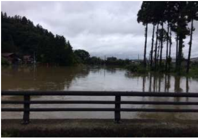
①新波川溢水状況
