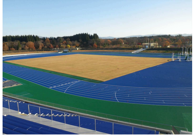
陸上競技場改修
