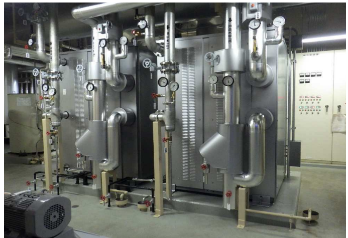
心身障害者コロニー冷温水発生機及び配管改修 (由利本荘市西目町)
