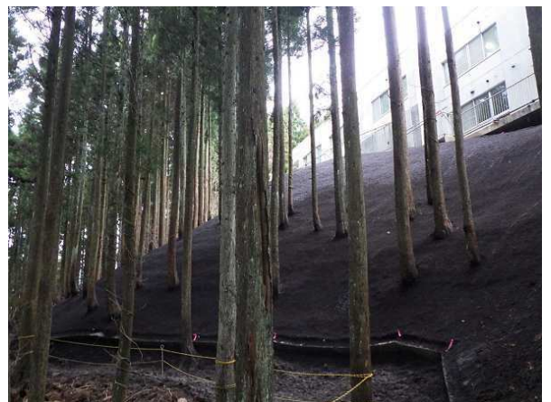
秋田市 河辺戸島地区 連続繊維補強土工
