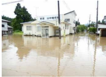
②新町地区浸水状況
