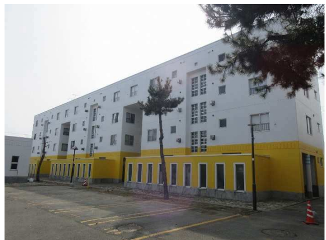
県営新屋住宅10号棟外壁・屋根防水改修工事
