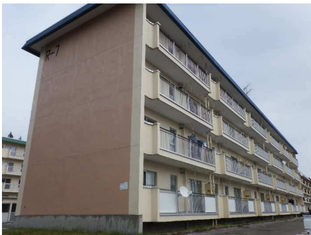
県営松崎住宅7号棟外壁改修工事
