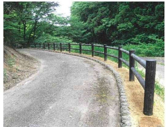
園路転落防止柵更新
