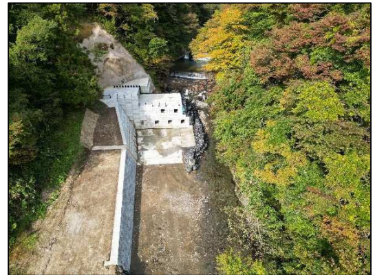
秋田市上新城白山 地内 部分透過型砂防堰堤
