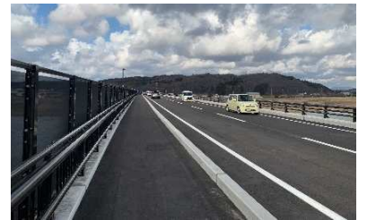
現在の水沢橋の状況
