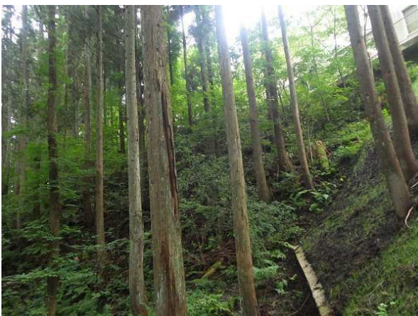
県単砂防工事(急傾斜地)
