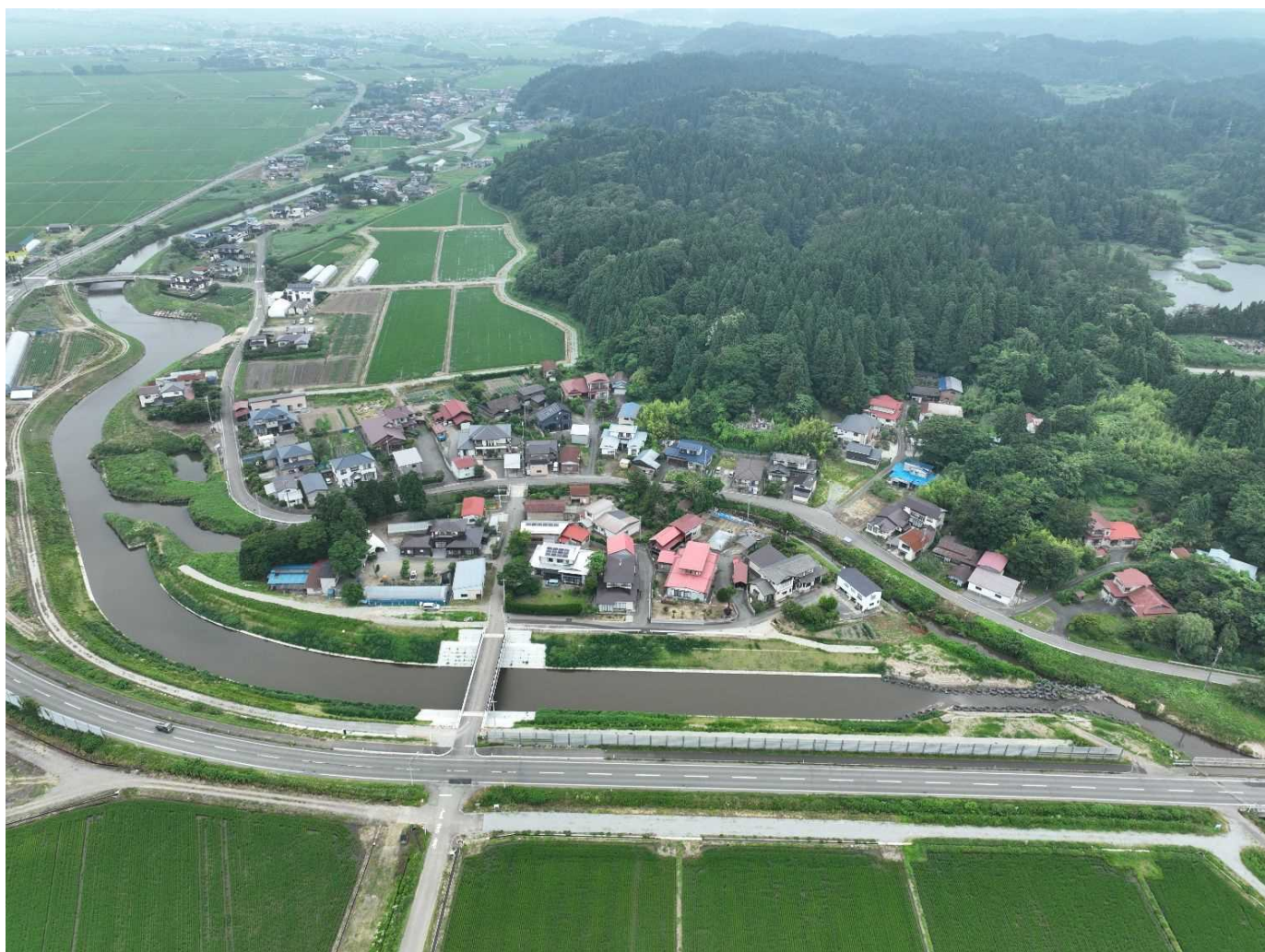
一級河川 馬踏川 堀内工区 秋田市金足堀内
