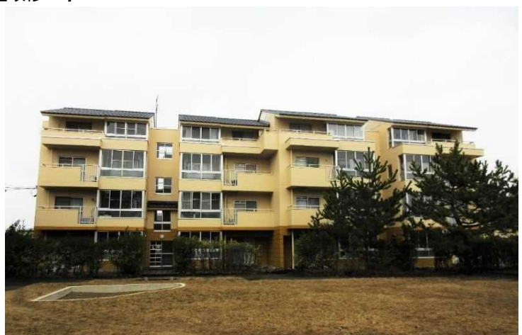
県営土崎港住宅4号棟外壁・屋根防水改修工事 (秋田市土崎港相染町)
