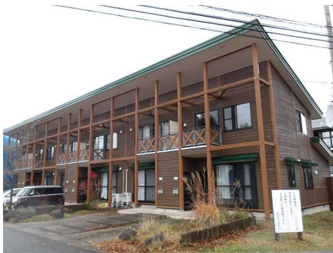
県営手形山1号住宅1号棟屋根・外壁改修工事 (秋田市手形山西町)
