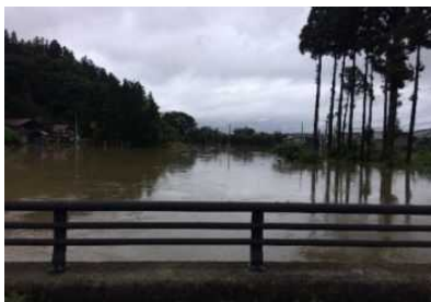
新波川溢水状況
