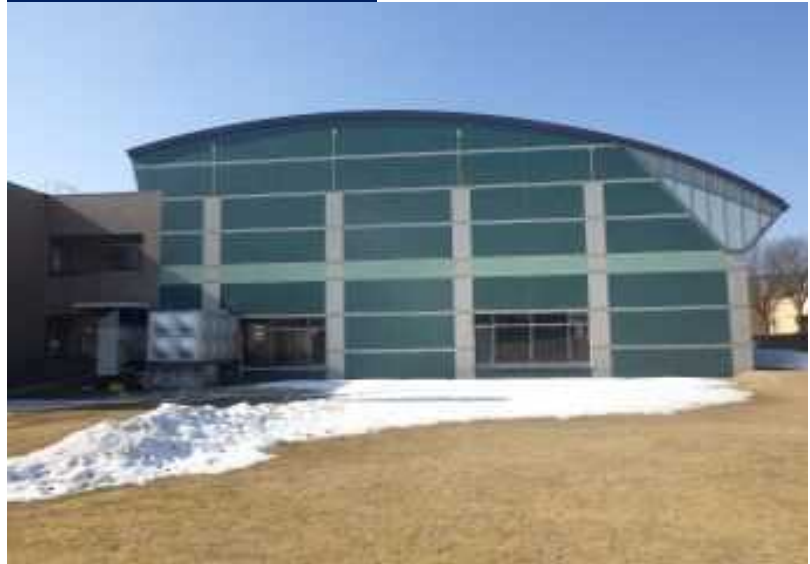
中央地区老人福祉総合エリア外壁改修工事 (秋田市御所野下堤)
