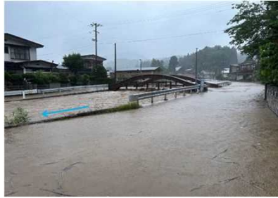
内川川氾濫状況(湯ノ又地区)
