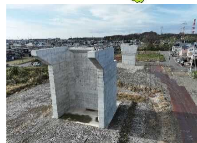
2号橋(A2橋台、P7橋脚)整備状況(R6.11)
