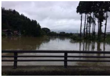
①新波川溢水状況
