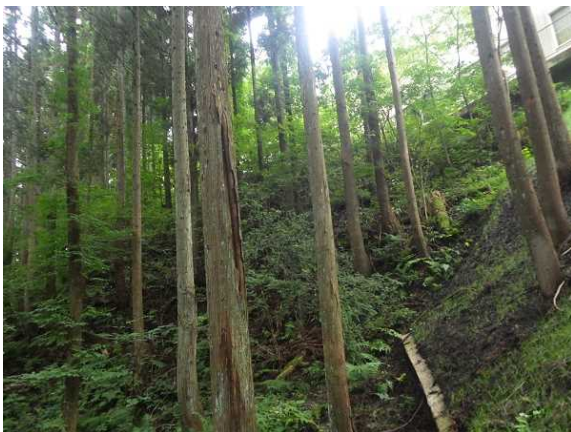
県単砂防工事(急傾斜地)
