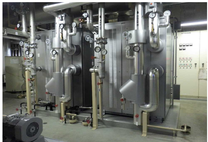
心身障害者コロニー冷温水発生機及び配管改修 (由利本荘市西目町)
