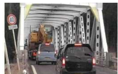
現道の水沢橋の状況
