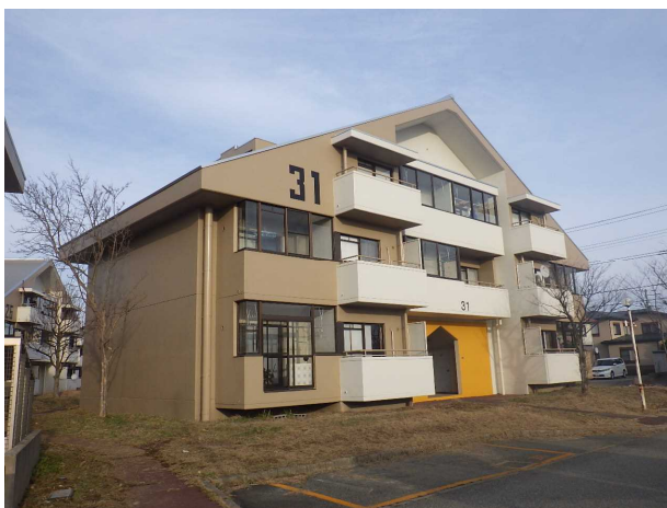
県営御野場第2住宅31号棟 外壁・屋根防水改修工事
