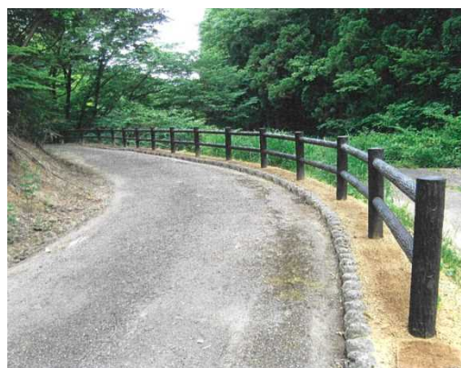
園路転落防止柵更新
