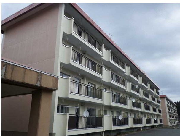
県営松崎住宅4号棟 外壁改修工事
