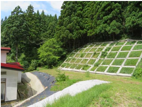
県単砂防工事(急傾斜地)
