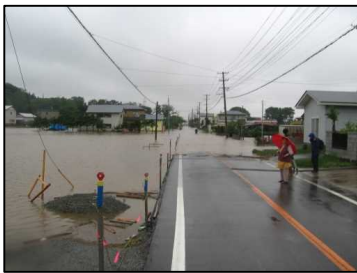
氾濫状況(下新城笠岡地内)
