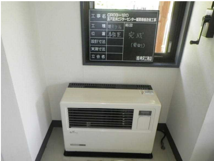
暖房機器設置完了後
