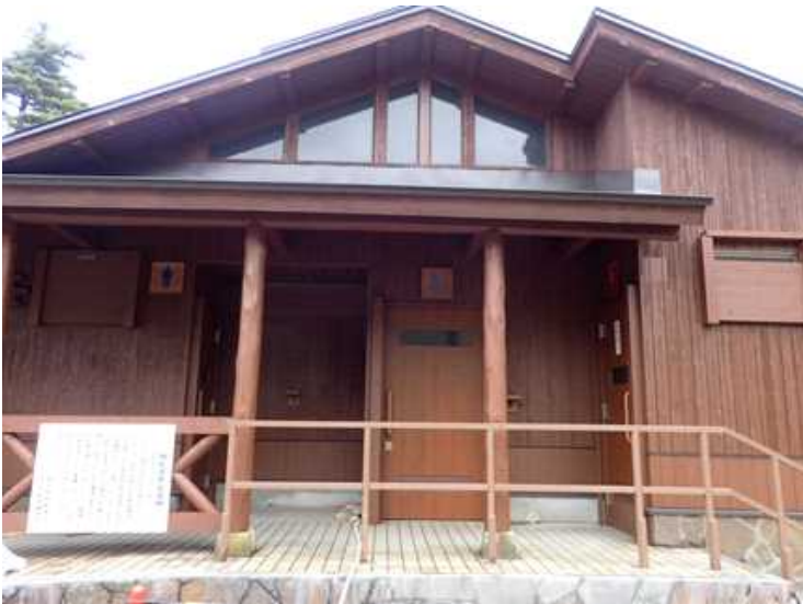
公衆トイレ改修完了後。
