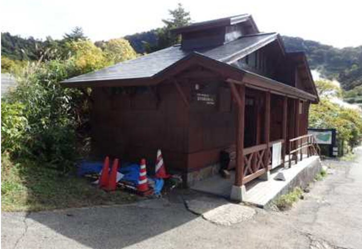
<トイレ全景> 公衆トイレ改修完了後。
