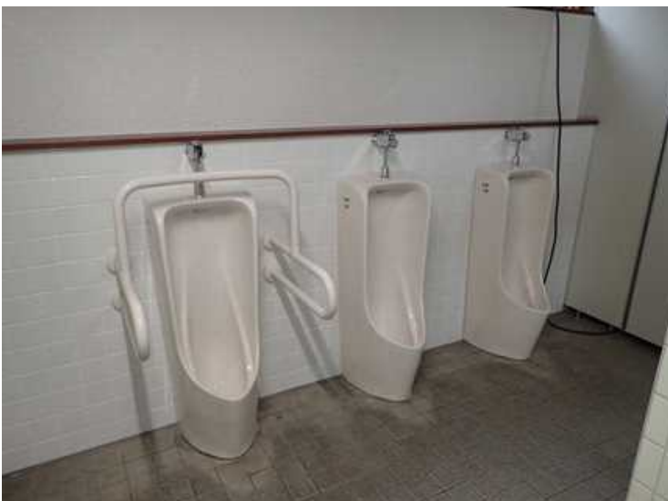
改修後の男子トイレ。
