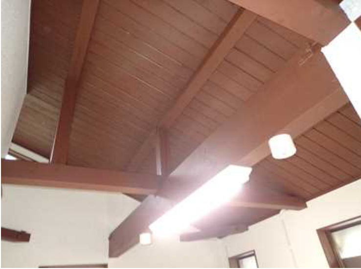
改修後の女子トイレ天井。
