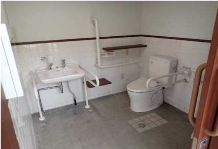
改修後の障害者トイレ。
