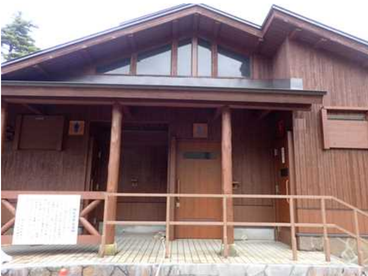
公衆トイレ改修完了後。
