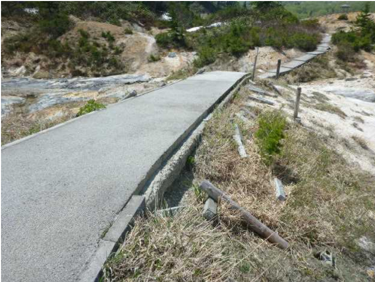
<園路> 歩道縁石とロープ柵の破損 状況
