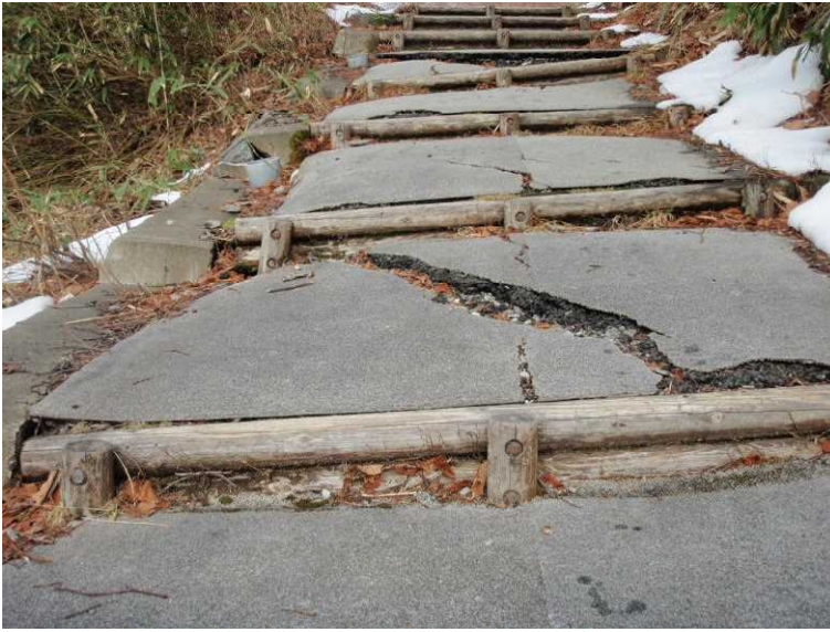
<園路> 老朽化による歩道階段部の 破損状況
