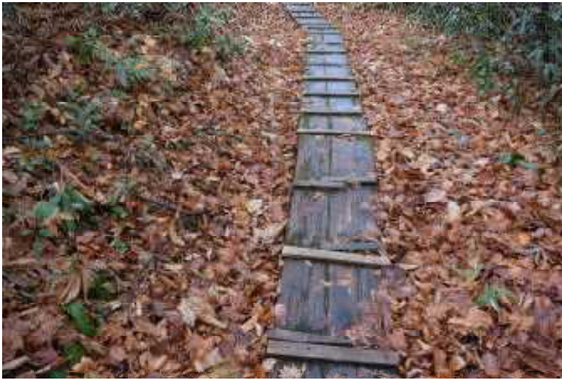
木道の老朽化の状況
