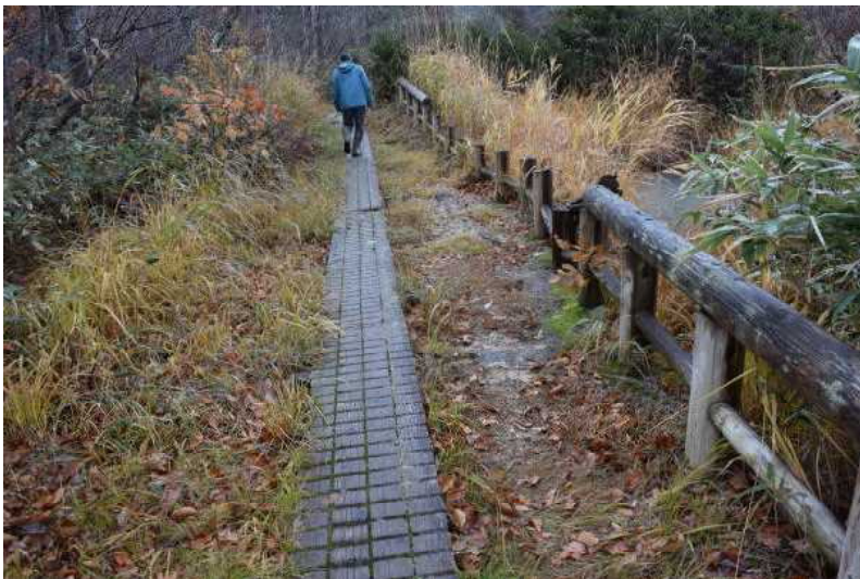
防護柵の老朽化の状況
