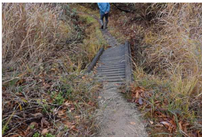
木橋が老朽化により傾いている。
