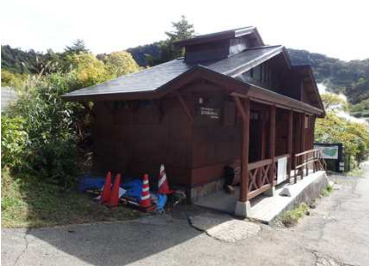
<トイレ全景> 公衆トイレ改修完了後。
