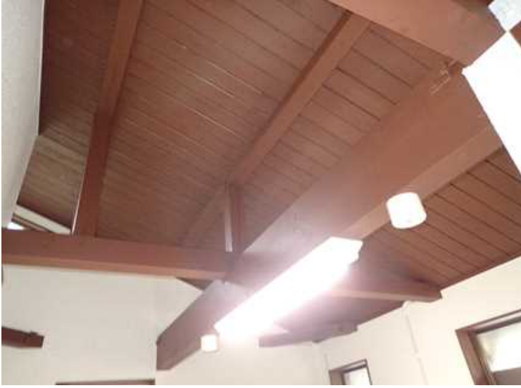
改修後の女子トイレ天井。
