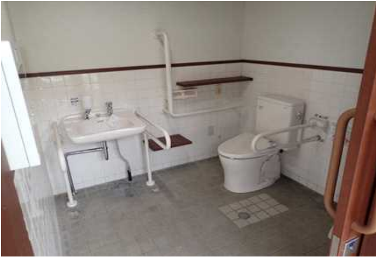
改修後の障害者トイレ。
