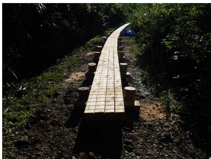
木道改修完了状況
