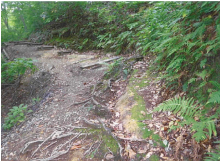
歩道の損壊状況
