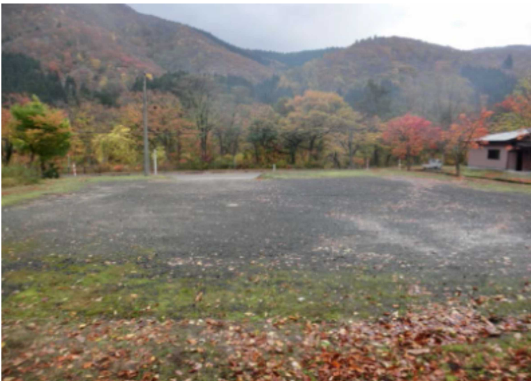
駐車場全景（奥側から） 未舗装箇所
