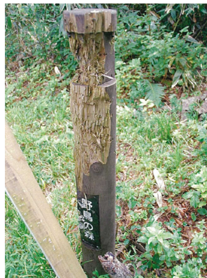
案内標識の腐食と損傷状況
