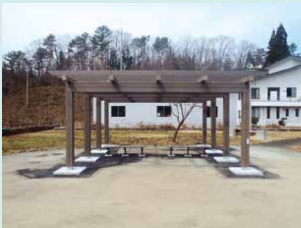
大館市：山瀬ダム 使用品目：再生有機系建材
