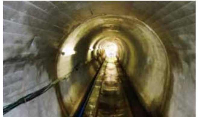
【用排水施設整備】 水路トンネルの改修 一ノ目潟地区（男鹿市）
