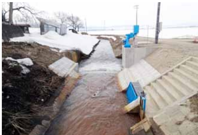
取水ゲート等の整備 二井田地区（横手市）
