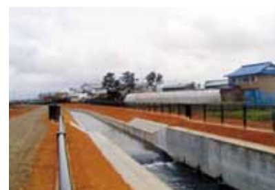
皆瀬第4号幹線用水路
