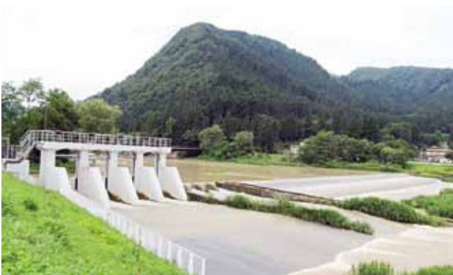
【農業用河川工作物応急対策】 頭首工の改修 稲庭地区（湯沢市）
