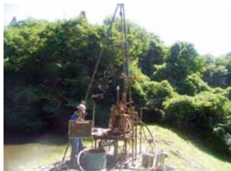
ため池のボーリング調査の様子
