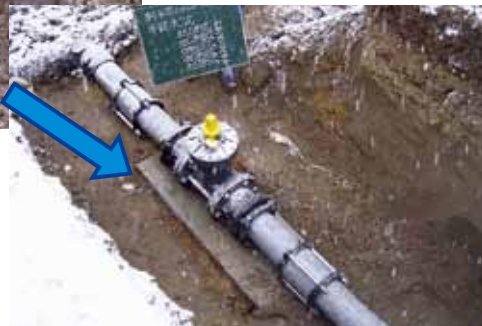
アスベスト管撤去 戸島内地区（北秋田市）
