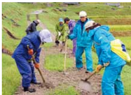
農道の砂利敷 横岡地区（にかほ市）
