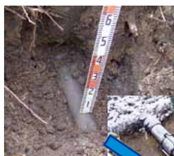
アスベスト管撤去 戸島内地区（北秋田市）
