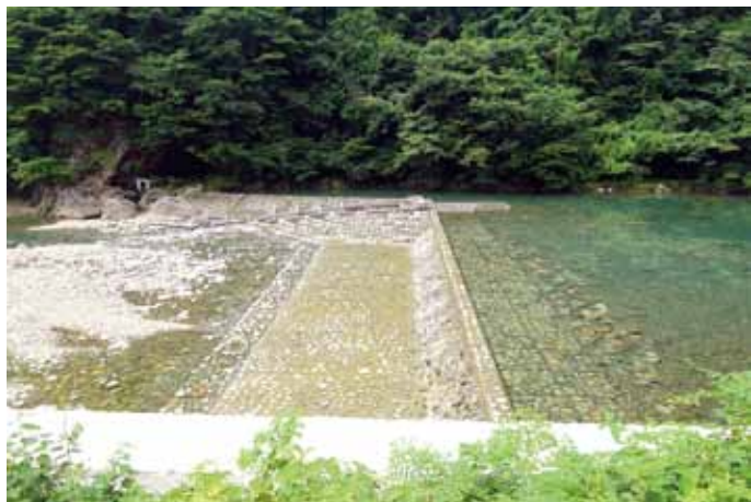
魚道の整備 若松堰地区（仙北市）
