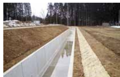
第二田沢幹線用水路
