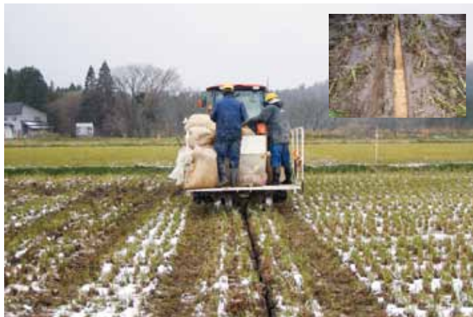
モミガラ補助暗渠の施工状況
