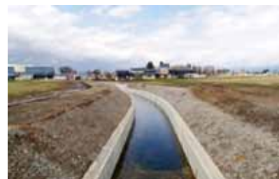
皆瀬2号幹線用水路
