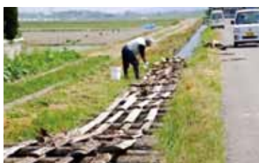
用水路安全防護柵無し
