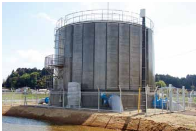
高架水槽の補修 八郎潟西部地区（男鹿市）
