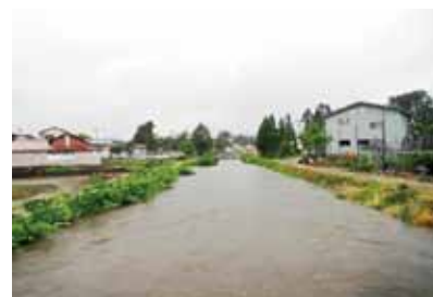
油川幹線用水路洪水状況
