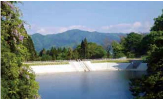
【ため池等整備】 老朽化ため池の改修 樽堤地区（由利本荘市）
