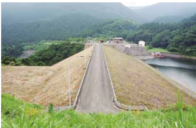
ダム施設の更新 水沢山地区（八峰町）
