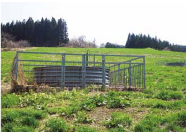
集水井の整備 沢内地区（由利本荘市）
