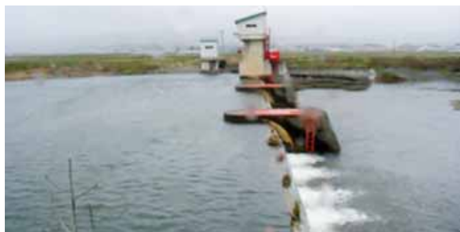
土砂吐ゲートの遠隔操作整備 羽後地区（羽後町）
