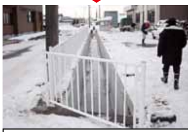
安全防護柵設置（イメージ）
