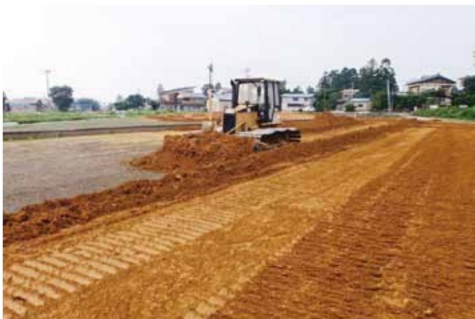
客土整備 亀福一期地区（横手市）
