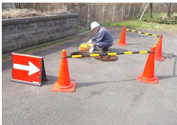
マンホールの点検
