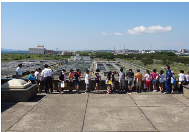
臨海処理センター
