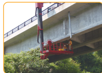
●橋梁点検作業
