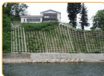
●土砂災害対策状況
