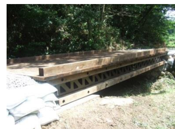
鋼材と木材のハイブリッド木橋
