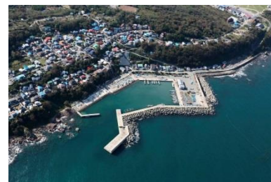
整備が進む畠漁港（男鹿市）
