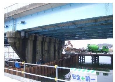
仮栈橋・鋼矢板を用いた仮締切の計画・施工
