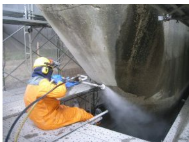
ウォータージェットによる素地調整
