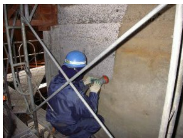
バキュームブラストによる素地調整
