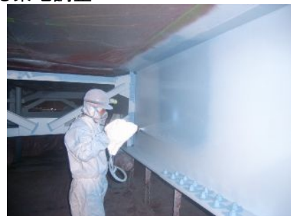
高塗着スプレー工法での施工
