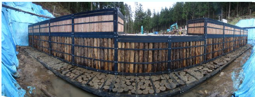
既設ダム工間の丸太柵工及び木製ブロック積側壁
