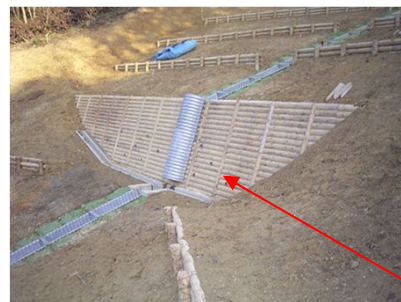
土留工 (木製残置型枠使用)
