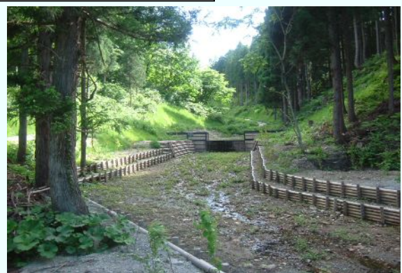
既設ダム工間の丸太柵工及び木製ブロック積側壁
