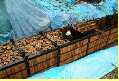
⑨天端太鼓落とし材の配置
