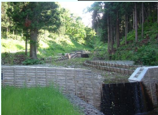
既設ダム工間の丸太柵工及び木製ブロック積側壁
