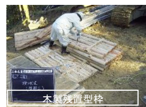
土留工 (木製残置型枠使用)
