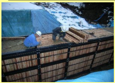
⑨天端太鼓落とし材の配置
