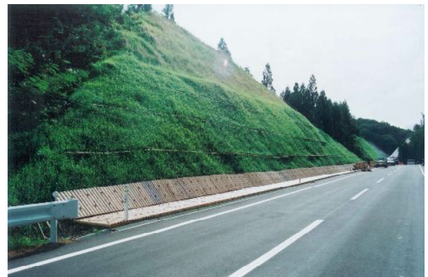
ユニット丸太施工状況
