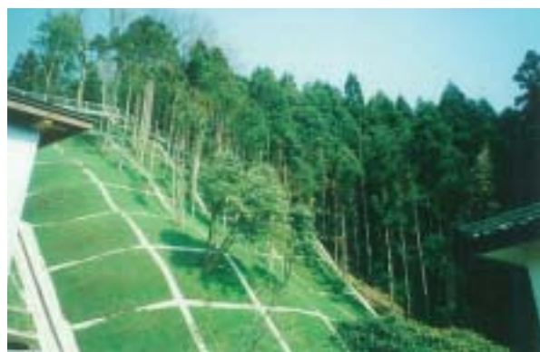
大間隔法枠工による既存木の保存（東由利町：蒲田地区）
