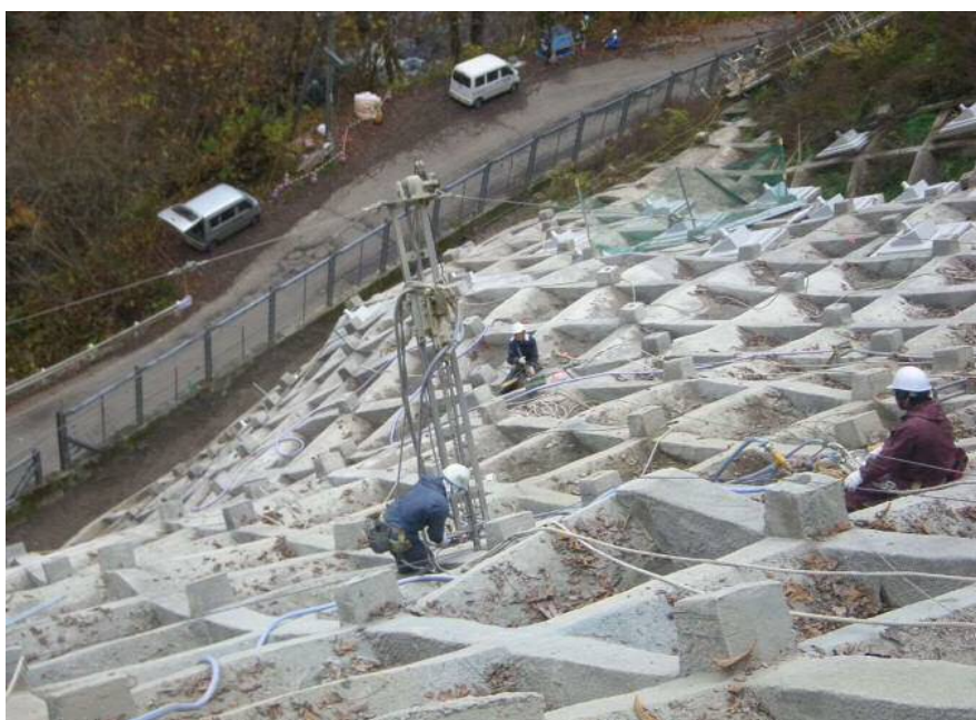
無足場アンカー工法による施工状況(交通規制無し)
