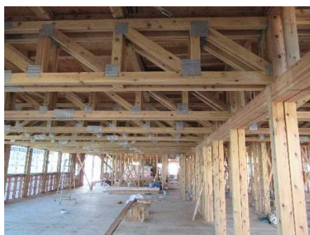
柱梁、秋田スギ主体の構造材、在来軸組工法
