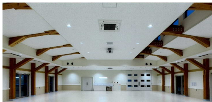
機能訓練室 (15mスパンを合掌梁とタイバーで天井高3.9mを確保)
