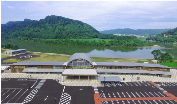
道の駅ふたつ外観
