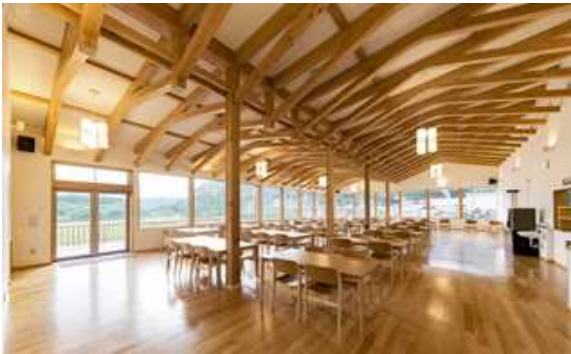
レストラン (方丈トラスの天井)
