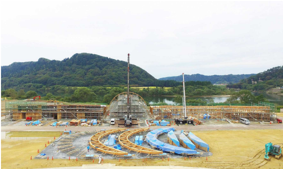
アーチトラス吊込状況
