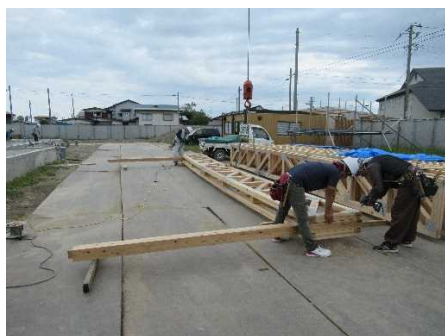
広いスパンのコネクトトラス梁、軽量で扱いやすく少人数での施工を可能にした
