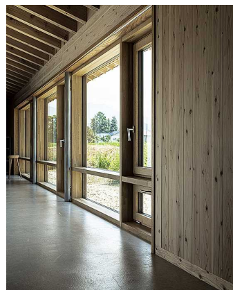
南面のカーテンウォールと漆喰塗の断熱壁
