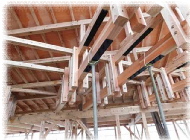
組立梁の施工状況
