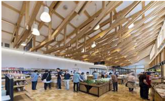
物販販売エリア (船底トラスの天井と、県産ナラ材を使用した床)
