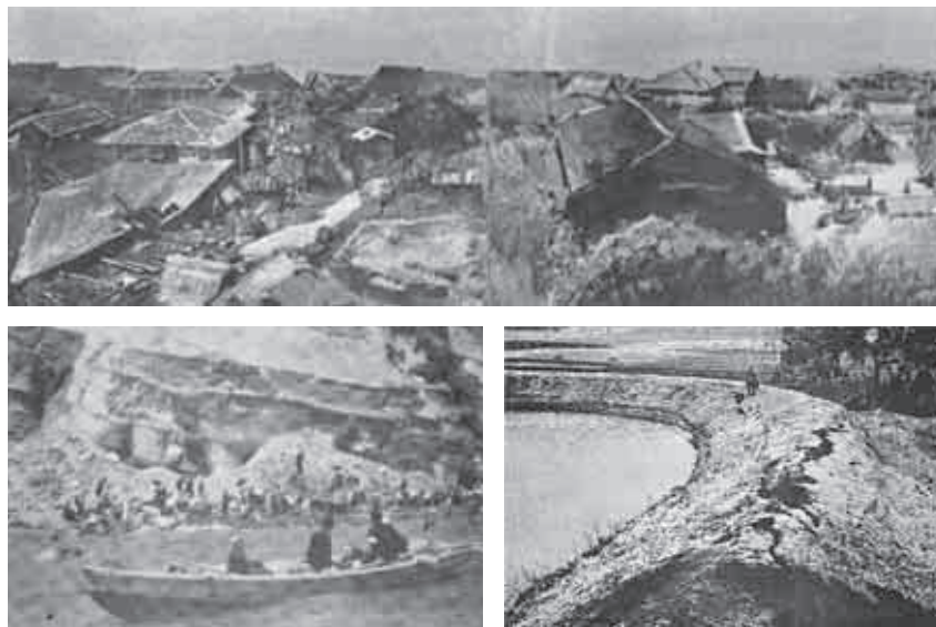
写真3 男鹿地震における被害の様子（『男鹿地方震災誌, 1942年』）
