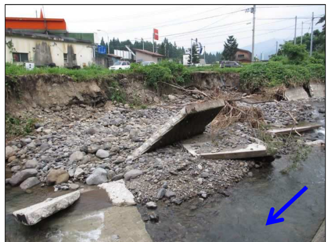
[現年発生土木災害復旧事業 小先達川 (仙北市)] 護岸工 (8月豪雨)
