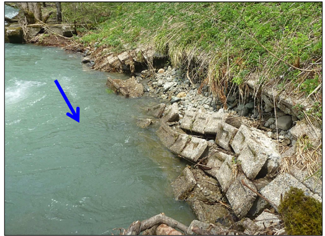
[県単河川改良工事 粕毛川 (藤里町)] 護岸工 (7月豪雨)
