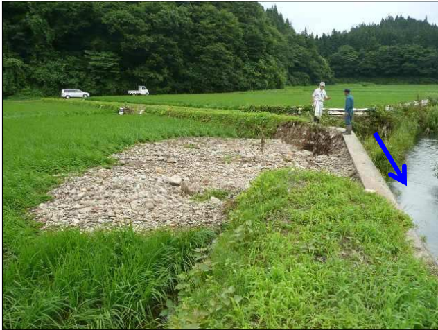
[県単河川改良工事 太平川 (秋田市)] 築堤の嵩上げ (7月豪雨)
