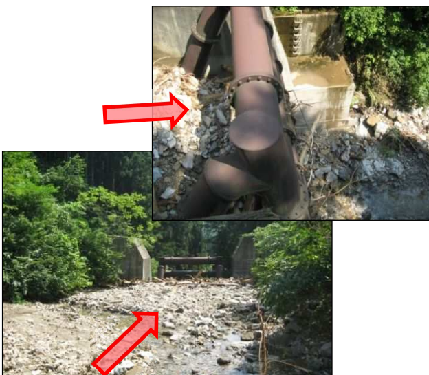
[県単砂防事業 小雪沢 (大館市)] 緊急除石工 (8月豪雨)
