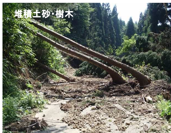
○土砂・樹木撤去
