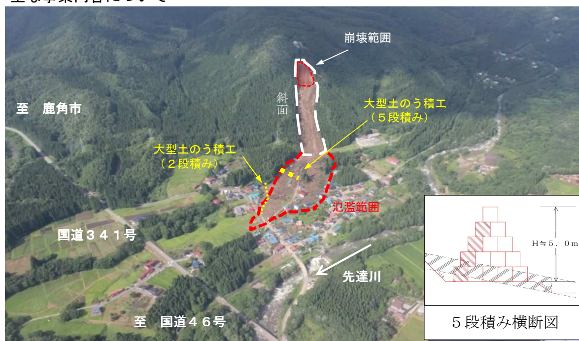
〔県単砂防事業 供養佛沢（仙北市）〕 大型土のう積、警戒避難体制検討
