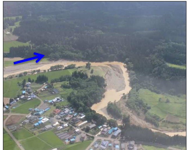
[県単河川等環境維持修繕事業 早口川 (大館市)] 河道掘削 (8月豪雨)
