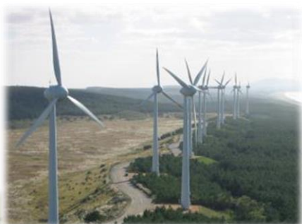
能代風力発電所
