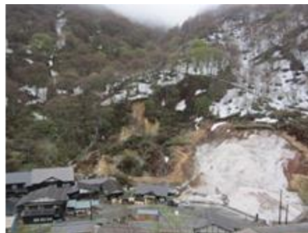
土砂災害発生状況（泥湯沢地区（湯沢市））
