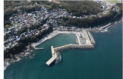
整備が進む畠漁港（男鹿市）
