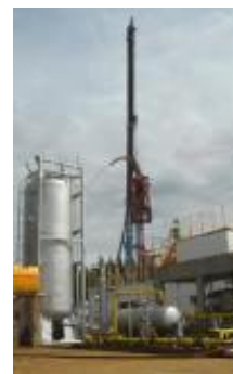
シェールオイル採掘試験 (由利本荘市)
