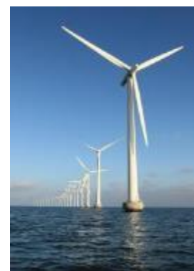
洋上風力発電 (デンマーク)
