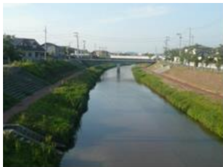
河川改修状況（草生津川（秋田市））
