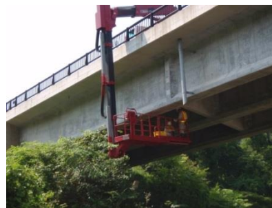
橋梁点検作業の様様
